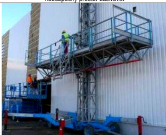
Montáž opláštění z bezpečných šplhacích plošin
