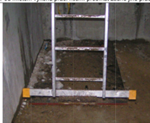
Žebřík zajištěný proti posunu dole
