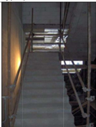
Zajištění schodišť pomocí kovové konstrukce z trubkového lešení
