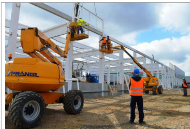
Montáž ocelové konstrukce z mobilních plošin s postroji
