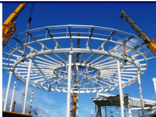
Předpřipravené konstrukce se následně zvednou do výšek k uchycení
