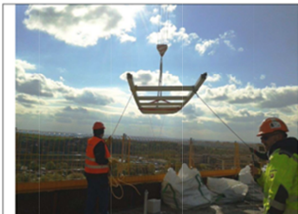
Přenos velkých dílů ocelovky se stabilizačními lany
