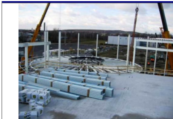
Jisté části ocelové konstrukce lze smontovat na zemi a vyhnout se přímým pracím ve výškách
