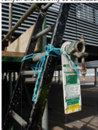
Žebřík zajištěný proti posunu nahore včetně dokladu o kontrole
