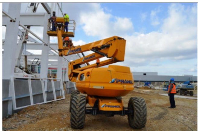
Montáž ocelovky z plošin s postroji
