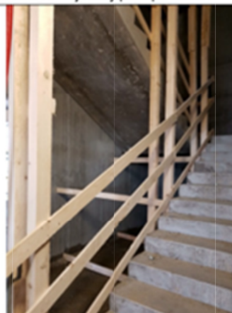
Zajištění schodišť pomocí tesařské konstrukce
