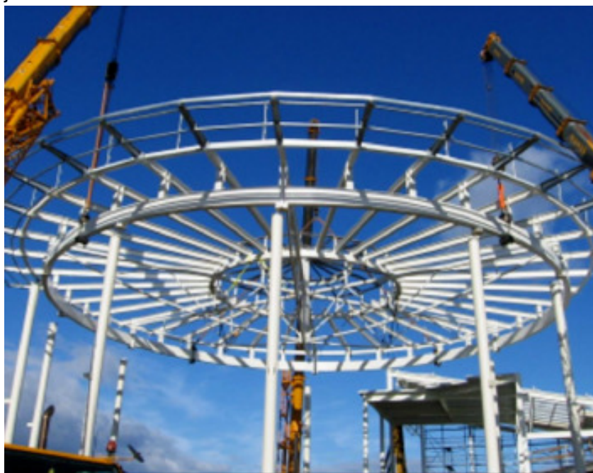
Minimalizované riziko při práci ve výškách, smontované díly konstrukcí na zemi jsou poté jednoduše zvedány do výšek
