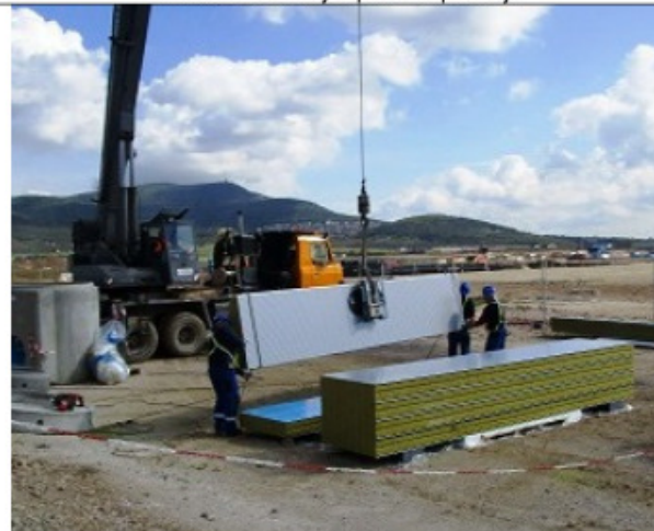
Přenášení opláštění mobilním jeřábem – vakuové úchytky
