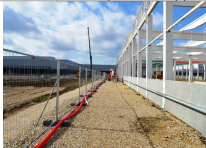
Montážní prostor - ohraničený a kvalitní podklad cesty pro plošiny
