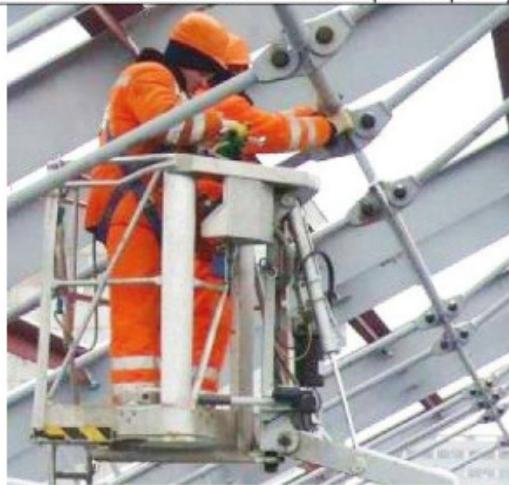
Detail montáže v plošinách s postroji
