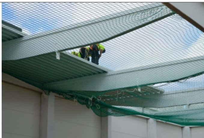
Montáž střešních h plechů nad sítěmi s postroji
