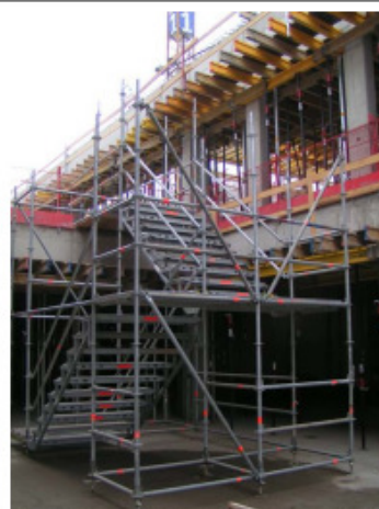
Vhodně řešený přístup na střechu - Systémové dočasné schodiště jako svislá komunikace
