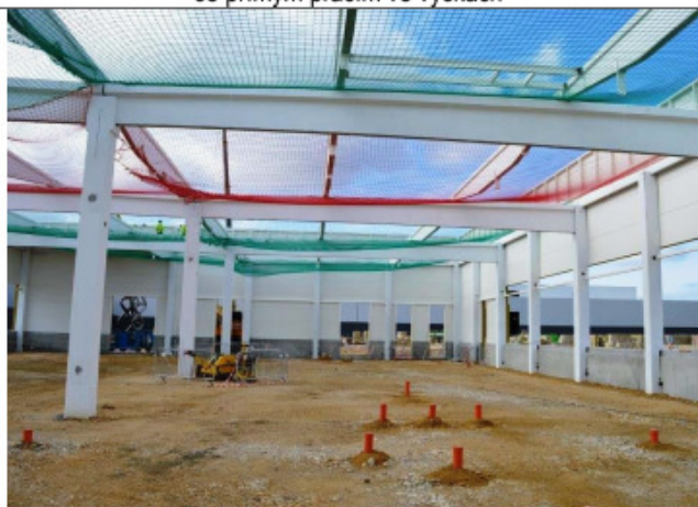
Příklad dobré praxe: před pokládkou střešních plechů se musí nebezpečný prostor zasítovat
