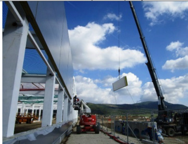
Při přenosu břemene jsou použita stabilizační lana
